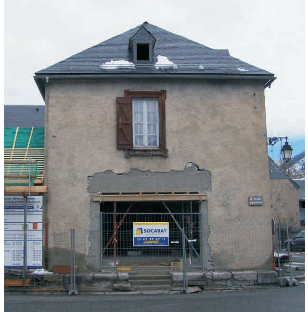
Etat initial - Façade côté place de la Mairie
